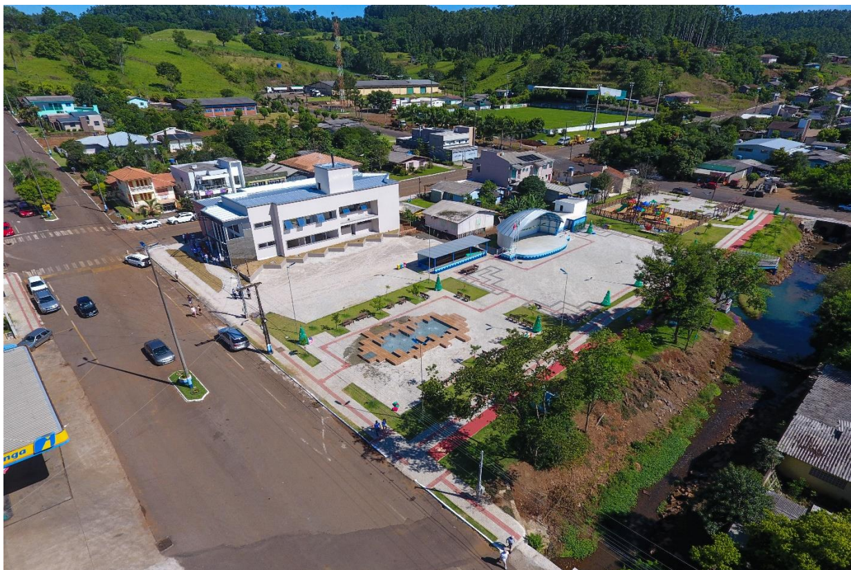
Vista do Novo Centro Administrativo Municipal de Águas Frias
